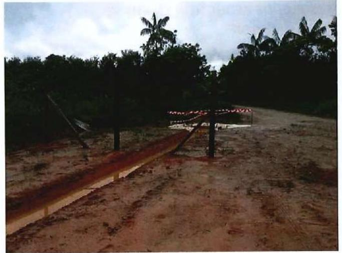
Exemple d'ouvrage de piégeage des matières en suspension mis en place en phase travaux (Chantier Portes de Soula, AGIR)
